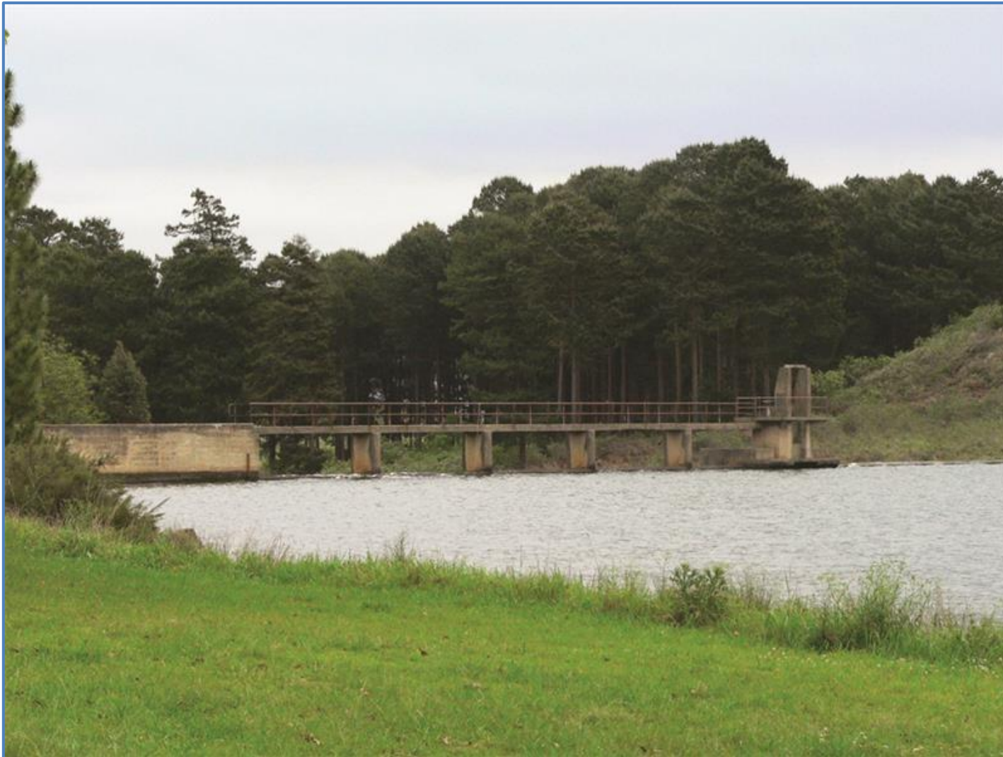
Figure 17.6 Grootgewacht Dam (DWA, 2015)
